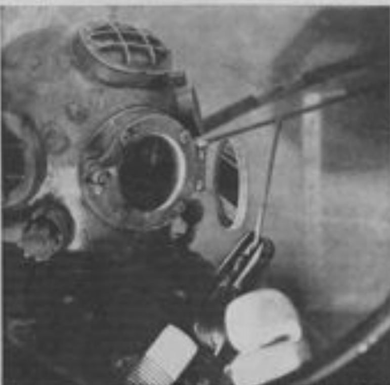
Schwelken unter Wasser ist nicht der Leichteste. Das Bild wurde durch ein Beobachtungsglas der Basine aufgenommen und zeigt die Einspannung der Schwelkenkappe.
